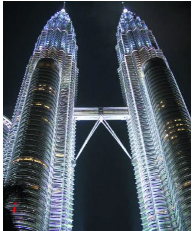
Les tours Petronas, en Malaisie, 88 étages, 452 mètres, ont nécessité 36 910 tonnes d'acier, pour un coût total de 1,6 milliard de dollars. Elles contiennent les bureaux du géant pétrolier malaisien Petronas, auquel elles appartiennent. Et plus d'un million de m 2 de boutiques et lieux de divertissement. Elles sont un symbole du modèle de développement inégalitaire actuel (la Malaisie n'est que 61 e sur 177 pays classés selon l'Indice de Développement Humain).
