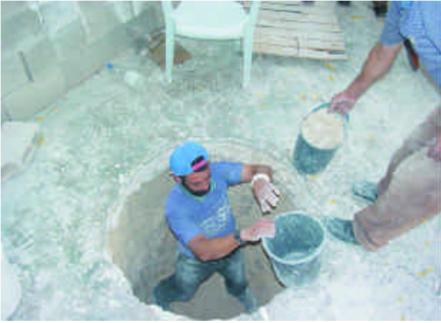
Ma'an a supervisé la restauration de puits et de serres, l'installation de canaux d'irrigation ainsi que la construction de réservoirs d'eau. Ici, un bénéficiaire creuse sa citerne-réservoir d'eau lui-même.
